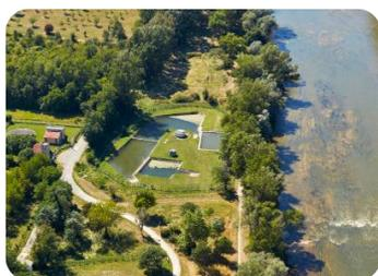
L'eau puisée dans l'Ariège transite par des bassins de décantation pourvus de filtre à sable. L'eau, une fois décantée, est acheminée vers une nappe souterraine avant d'être stockée dans un réservoir. En fonction des besoins, l'eau est ensuite transférée du réservoir au château d'eau de Pinsaguel où elle est chlorée pour être rendue prête à la consommation.
