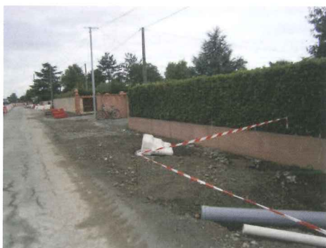
Pendant les travaux
